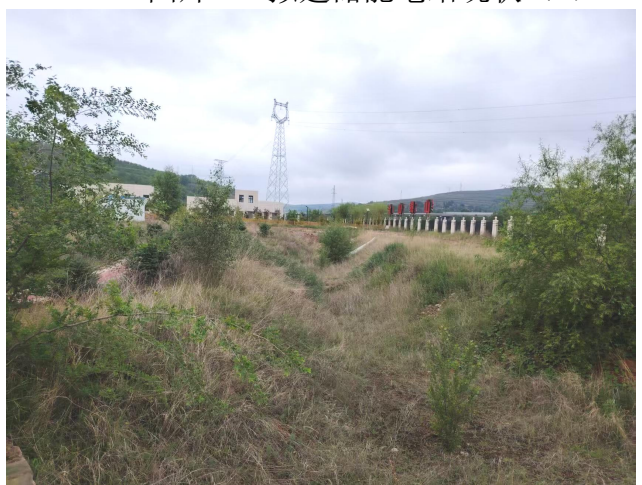
图片 3 拟建储能电站现状（3）
