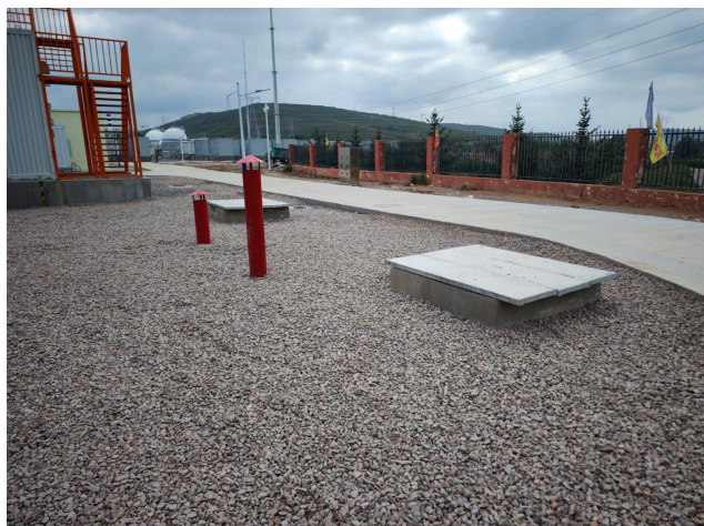
图片 11 现有工程事故油池
