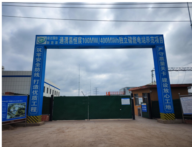
图片 7 现有工程门口
