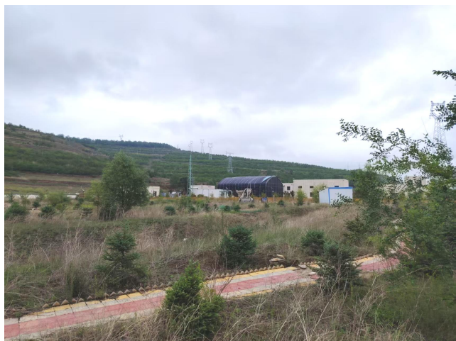
图片 1 拟建储能电站现状（1）
