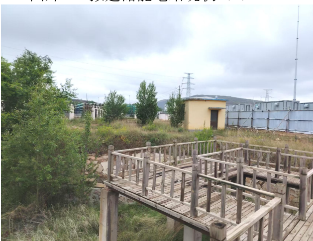
图片 4 拟建储能电站现状（4）
